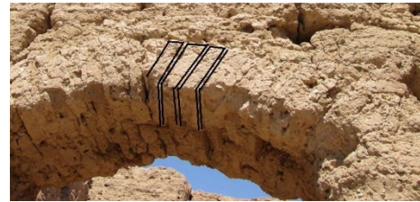
شکل ۱۲. نحوه تاق‌زنی به شیوه رومی در گاه ایوان‌ها، دستگردان (Authors, 2018)
