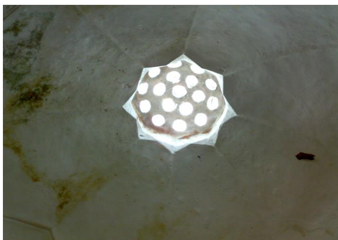
روزن مشبک سقف حمام
