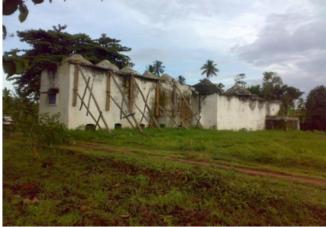
تعمیر ترک‌های ضلع جنوبی بنا
